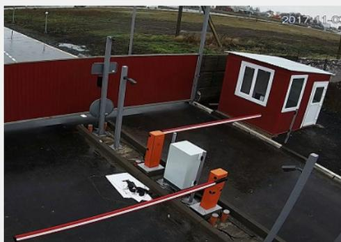
Система «Автомаршал» обеспечивает контроль доступа автомобильного транспорта на территорию двух заводов Fazer через 8 КПП. Ведется учет водителей и пассажиров. Для ускорения и удобства работы операторов в системе ведутся справочники с самыми часто используемыми данными.
